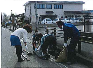
側溝土砂上げの様子
